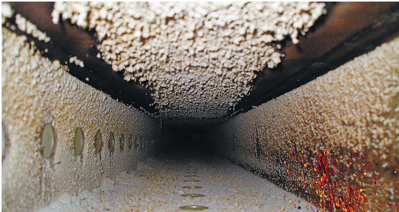
Tali depositi di farina nel condotto dell'aria di scarico sono un pericolo di incendio.
